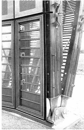
Anclaje de puntales de madera mediante apoyo fijo.
