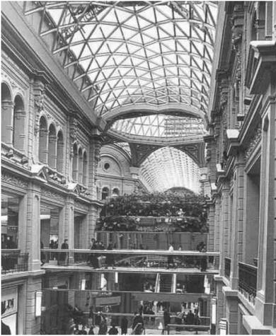
**Bóvedas de cañón trianguladas:** son indicadas para grandes luces por su *ligereza, resistencia y ausencia de encofrados* para su construcción, que representan algunos de los inconvenientes de las mismas al ser materializadas en hormigón, además de sus posibilidades de adaptación y su condición de autosustentantes evitando tensores y contrafuertes.
