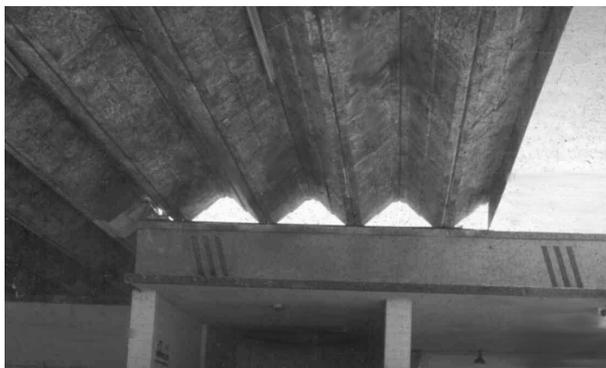
Plegado de cubierta en hormigón armado.
