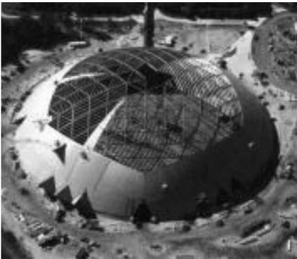
**Cúpulas trianguladas:** las estructuras reticuladas se pueden materializar con elementos metálicos de acero o aluminio, pudiéndose cerrar los espacios entre barras para conformar la cubierta con materiales diversos, maleables a fin de adaptarlos a formas tales como: plásticos, vidrios de alta tecnología, lonas, chapas de acero o aluminio, etc.
